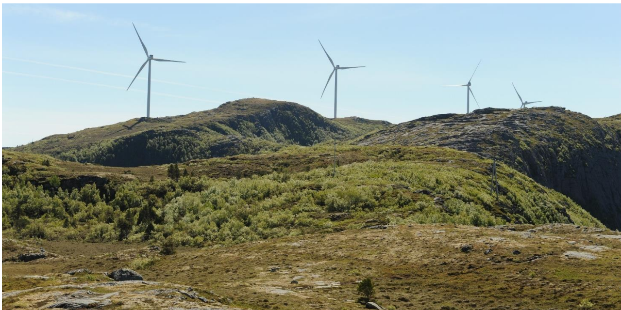
Figur 4-11 Utsyn mot Roan vindkraftverk og eksisterende 24 kV- kraftledning i sørøst.
