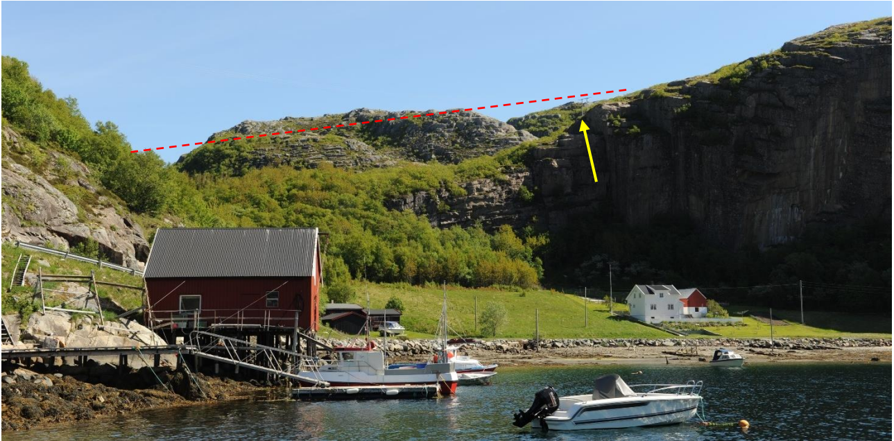
Figur 5-7 Spennet fra Vikafjellet til Brattlia bak Buavika er indikert med rød strek. Dagens 22 kV-mast kan skimtes (gul pil). Bearbeiding av samme motiv som Figur 4-4.
