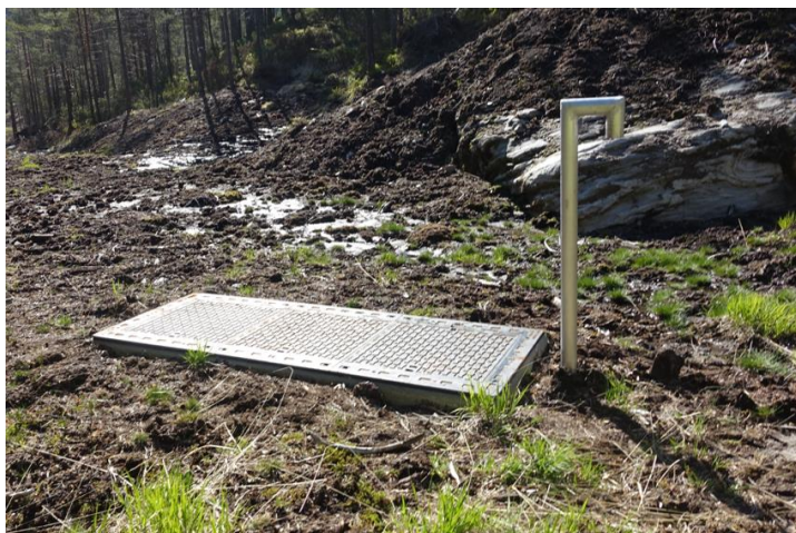
Figur 7: Eksempel på luftekum i hver ende av mikrotunellen.
