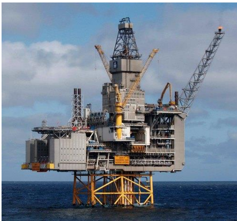
Figur 3-11 Oseberg Sør-innretningen. Foto: Norsk oljemuseum.
